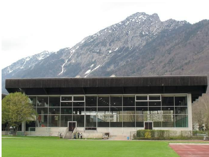
Bild 1: Eissporthalle in Bad Reichenhall, Ansicht der schmalen Front
