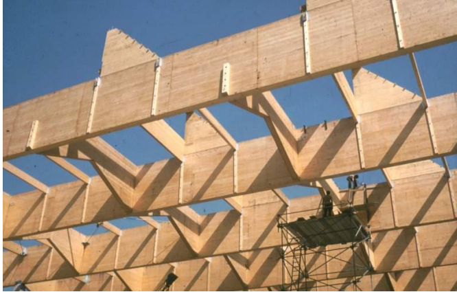
Bild 3: Hölzernes Dachtragwerk im Bauzustand
